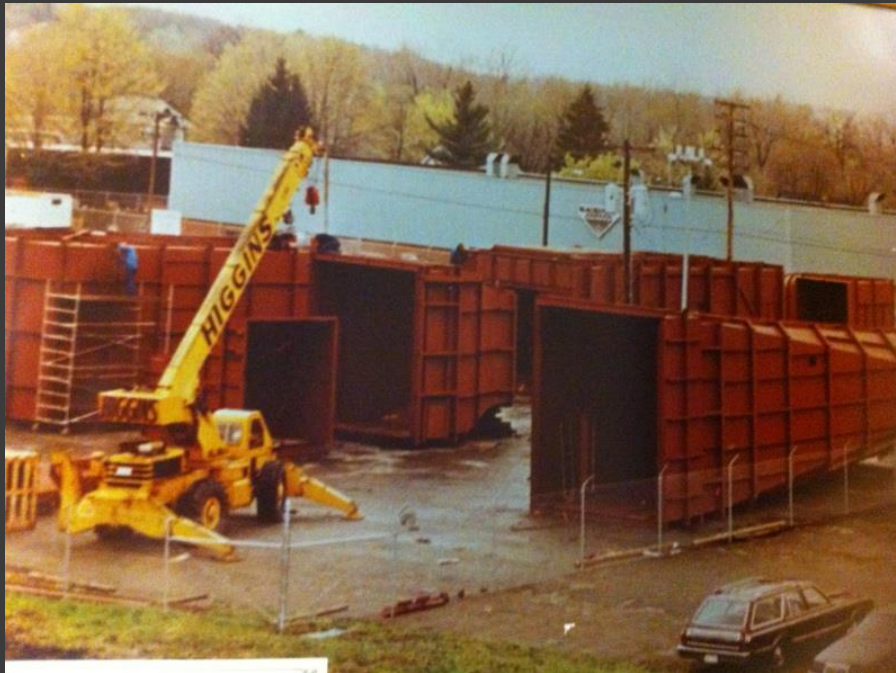
Montage av vindtunnel i USA.
