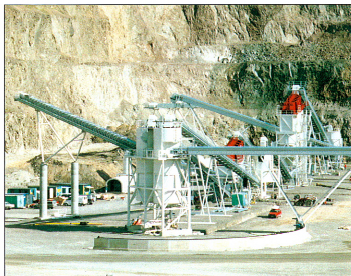
Den nya anläggningen byggs nere i brottet, 35 meter under marknivån och är helt dammkapslad.
