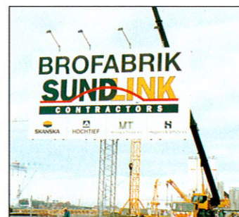
I Norra hamnen i Malmö har Sundlink sin brofabrik där delar till Öresundsbron tillverkas.
