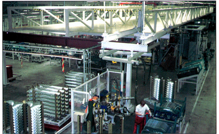
Stålbjälklaget har monterats över befintlig produktionslinje under pågående produktion i 2-skift.
