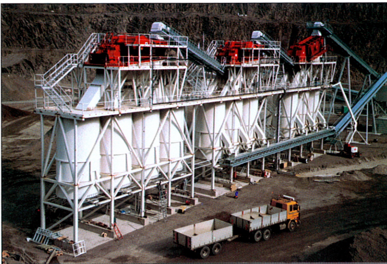
Tio silos ingick bl a i Stål & Rörmontages åtagande i den andra etappen i Skånska Makadams krossanläggning i Åstorp. (Totalhöjden är ca 25 meter.)
